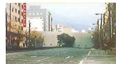
倒壊し避難路を塞いだ建築物
